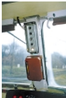
Блок приемника с индикатором устройства ТСКБМ в кабине автомотрисы AR2-01
